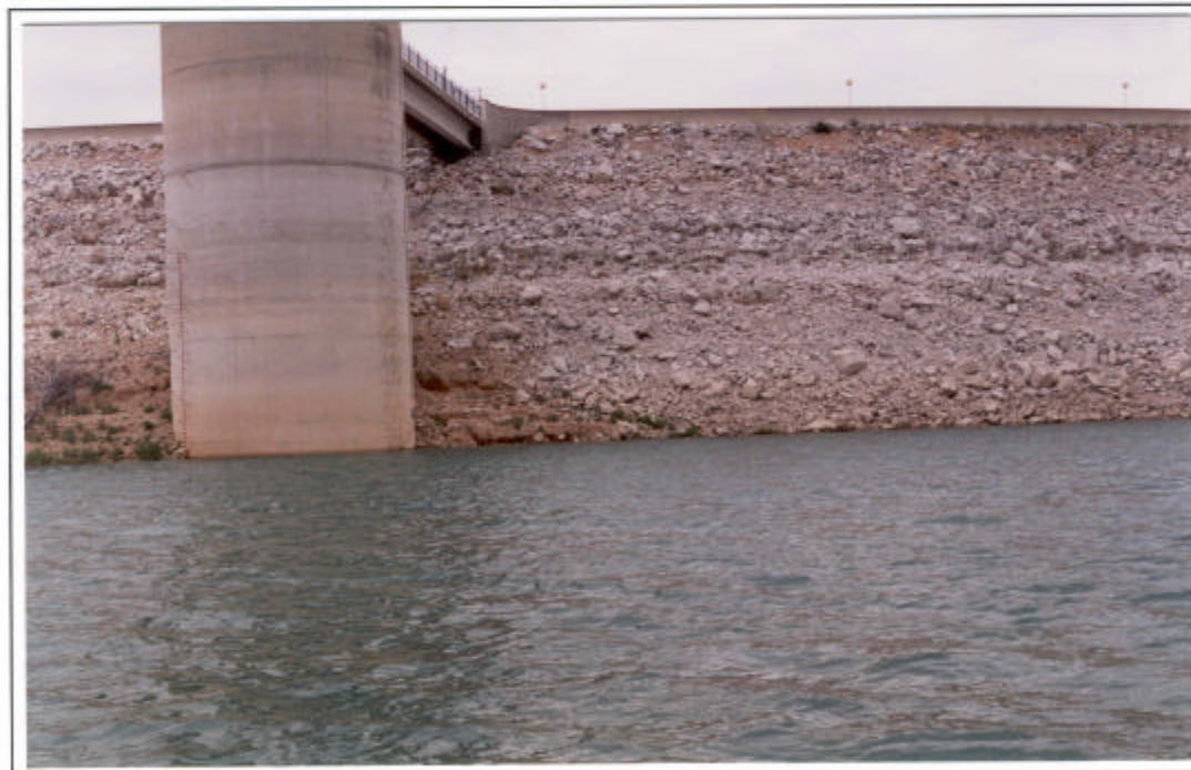
Presa de Calanda y desagüe de fondo.
