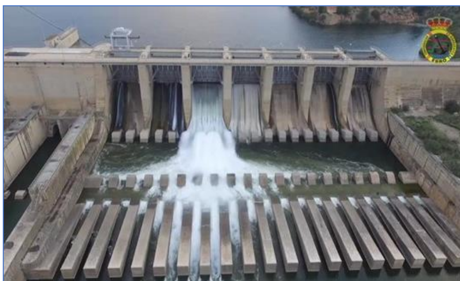
Aliviadero de la presa de Flix durante maniobras de apertura.
