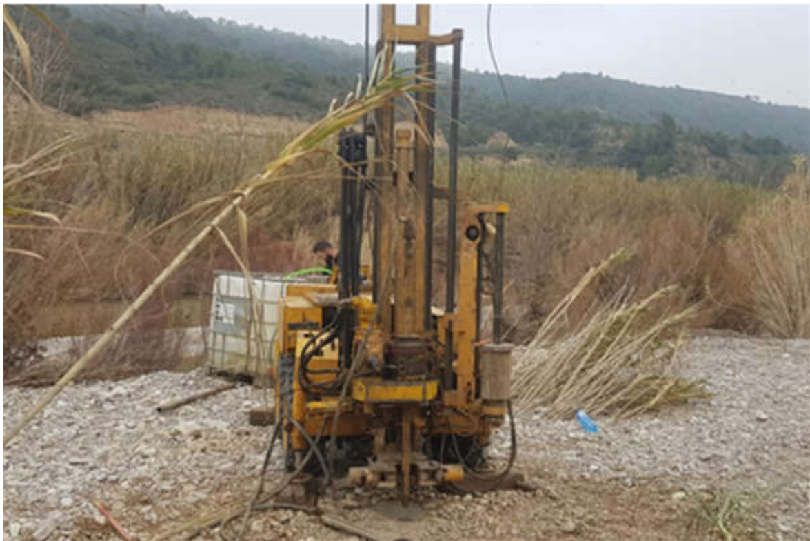
Figura 59. Máquina de sondeos trabajando en SR-01.
