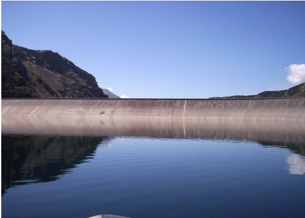
Detalle de la presa del embalse de Sallente. Verano de 2004 (06/08/2004)
