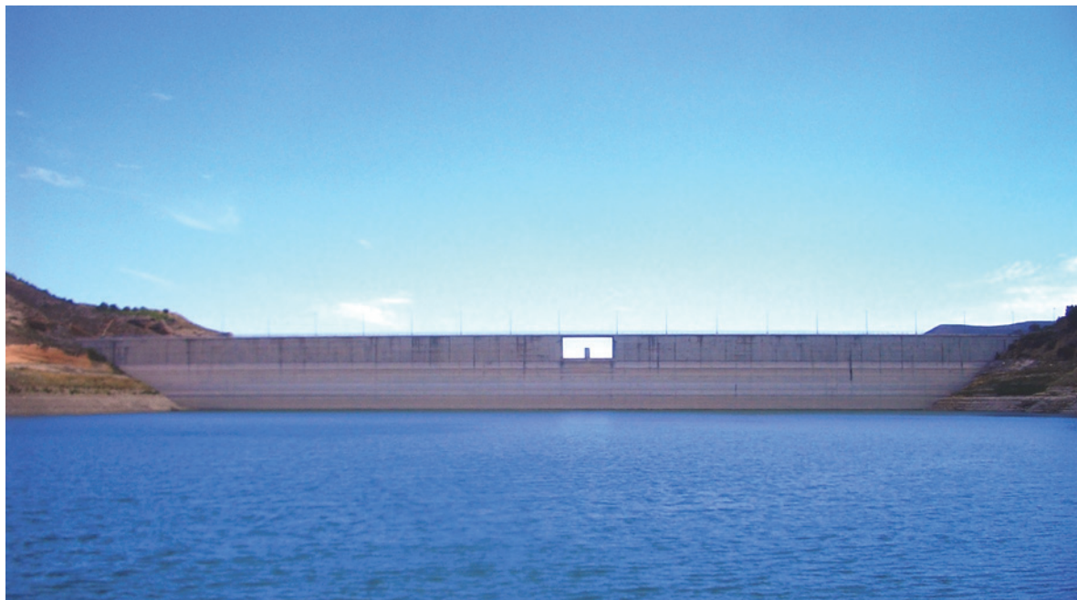
Figura 7: Vista de la presa del embalse
