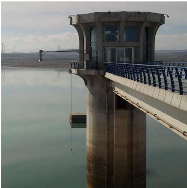
La sonda se ha instalado en la torre de acceso a la cámara de válvulas.
